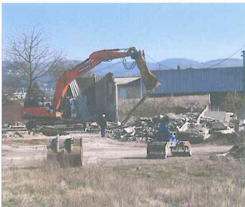
Les démolitions se poursuivent sur l'espace Beaunier. Avec l'acquisition des terrains Perrin Pichon, le projet d'une résidence services seniors va voir le jour. Photo Progrès/Pierre THIOLIERE
