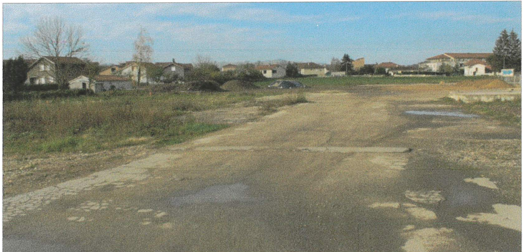
La voirie d'accès à l'ancien lotissement industriel du Triolet (au premier plan) n'a plus lieu d'exister. Au fond sera construite la résidence service seniors, à laquelle on accèdera par la rue de l'Espoir. Photo Progrès/Pierre THIOLIERE
