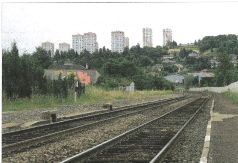
L'implantation d'une passerelle au-dessus de la voie ferrée permettrait d'assurer une liaison piétonne entre l'Hippodrome (à gauche) et l'espace Beaunier (à droite). La commune a désormais la maîtrise foncière pour envisager cette éventualité. Photo Progrès/Pierre THIOLIERE
