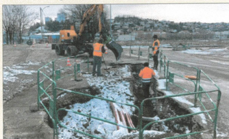
Après le changement des réseaux d'eau et d'assainissement, c'est tout le carrefour qui sera réaménagé.
