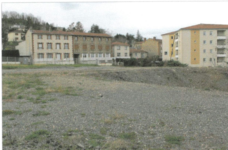
Le terrain de l'ex-garage Renault accueillera un parking public et des petits immeubles, pour un total de 46 logements annoncés. Photo Progrès/Pierre THIOLIERE
