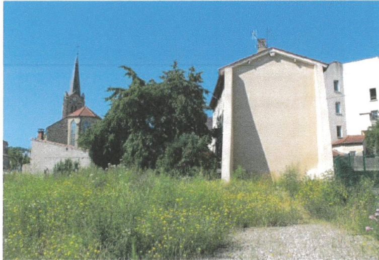
Les dernières maisons situées rue Paul Bert viennent d'être achetées à l'amiable par la mairie. Elles seront démolies en 2024 ouvrant ainsi un large accès entre la place Gambetta et l'espace Beaunier. Photo Pierre Thiollière
